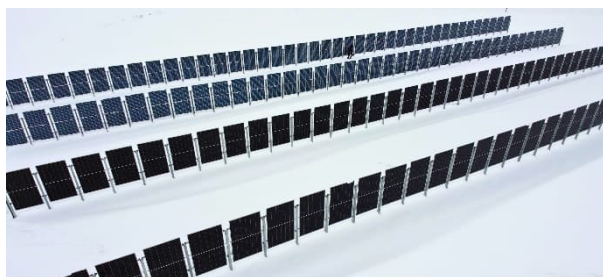
Figur 3. Vertikalt placerade solcellspaneler i pilotanläggning Lilla Norrskenet (Foto: Sunna Group).
